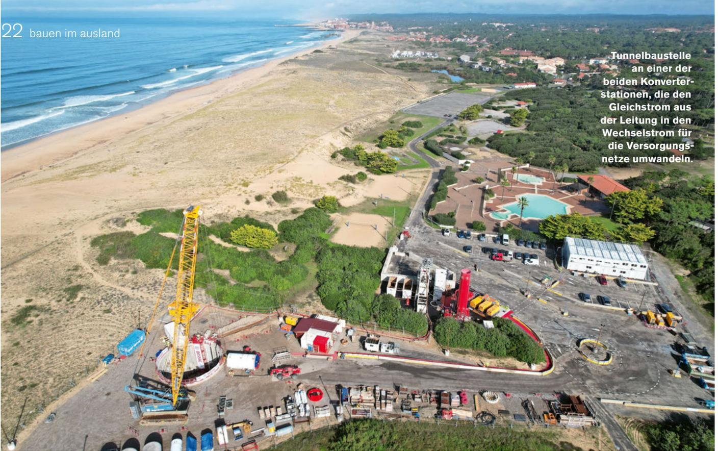
Tunnelbaustelle an einer der beiden Konverterstationen, die den Gleichstrom aus der Leitung in den Wechselstrom für die Versorgungsnetze umwandeln.
