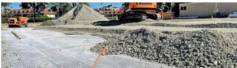
Durch die schlankere Bauweise kann bis zu 50 Prozent Kies eingespart werden. Das führt zu einer Halbierung der Baustellentransporte und schont die begrenzte Ressource Kies.
