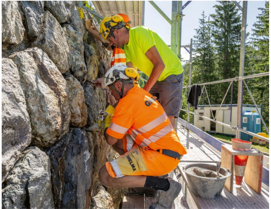
Wurde ein Mauerteil von Wasser hinterspült, heisst es, die Mauer Stein um Stein ab- und anschliessend gleich wieder aufzubauen.
