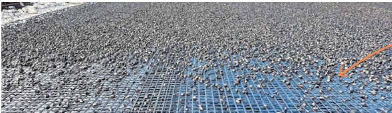
**Gerissene Trag- und Binderschichten müssen nicht ausgetauscht werden. Neue Deckbeläge bleiben dank der Asphaltarmierung rissfrei und stehen langfristig im Einsatz.**
