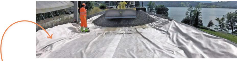
Wird anstelle einer zehn Zentimeter dicken, mineralischen Schüttung ein Geotextil für die Funktionen Trennen/Filtern eingesetzt, reduziert sich der Energiebedarf um rund 85 und der CO<sub>2</sub>-Ausstoss um fast 90 Prozent.
