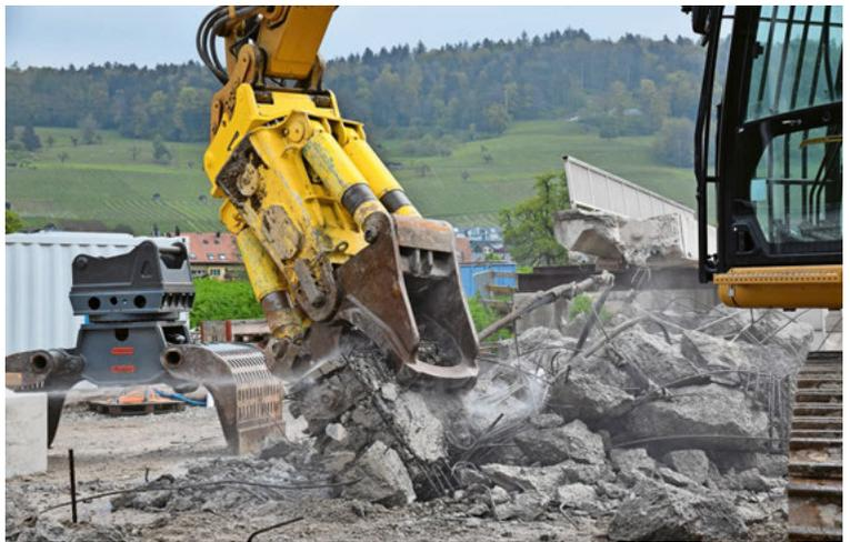
Das Kastenmaulgebiss trennt Beton und Armierung in einem Arbeitsgang.
