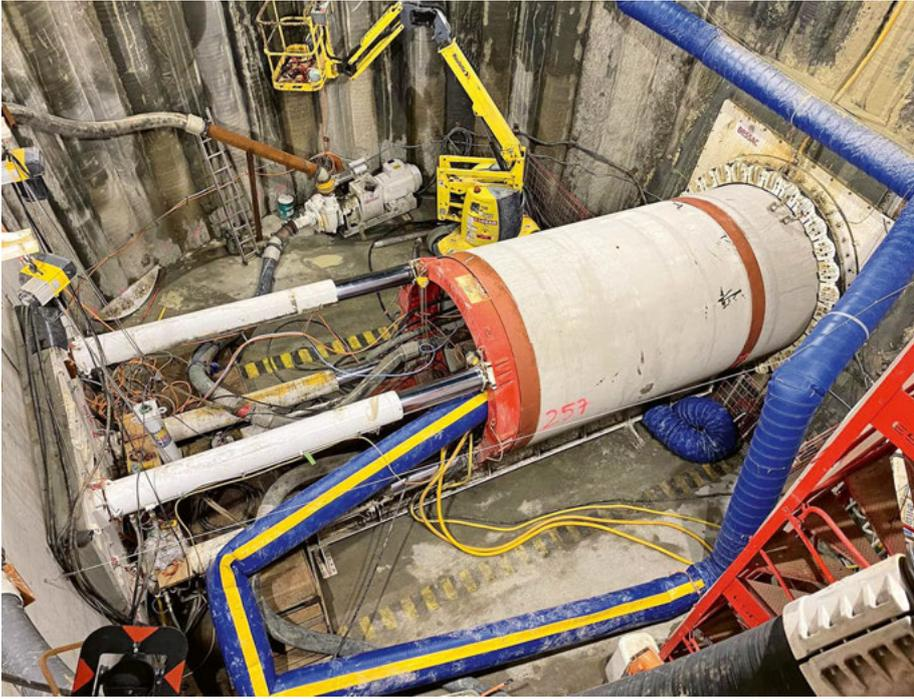
Die Tunnelbohrmaschine fräst einen begehbaren Stollen von drei Meter Durchmesser.
