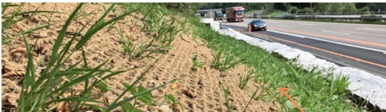
**Der Erosionsschutz sichert die Böschung, bis der Bewuchs diese Aufgabe wahrnehmen kann. Damit werden Schäden an Böschungen vermieden. Einmal korrekt gebaut, sind keine Reparaturen notwendig.**
