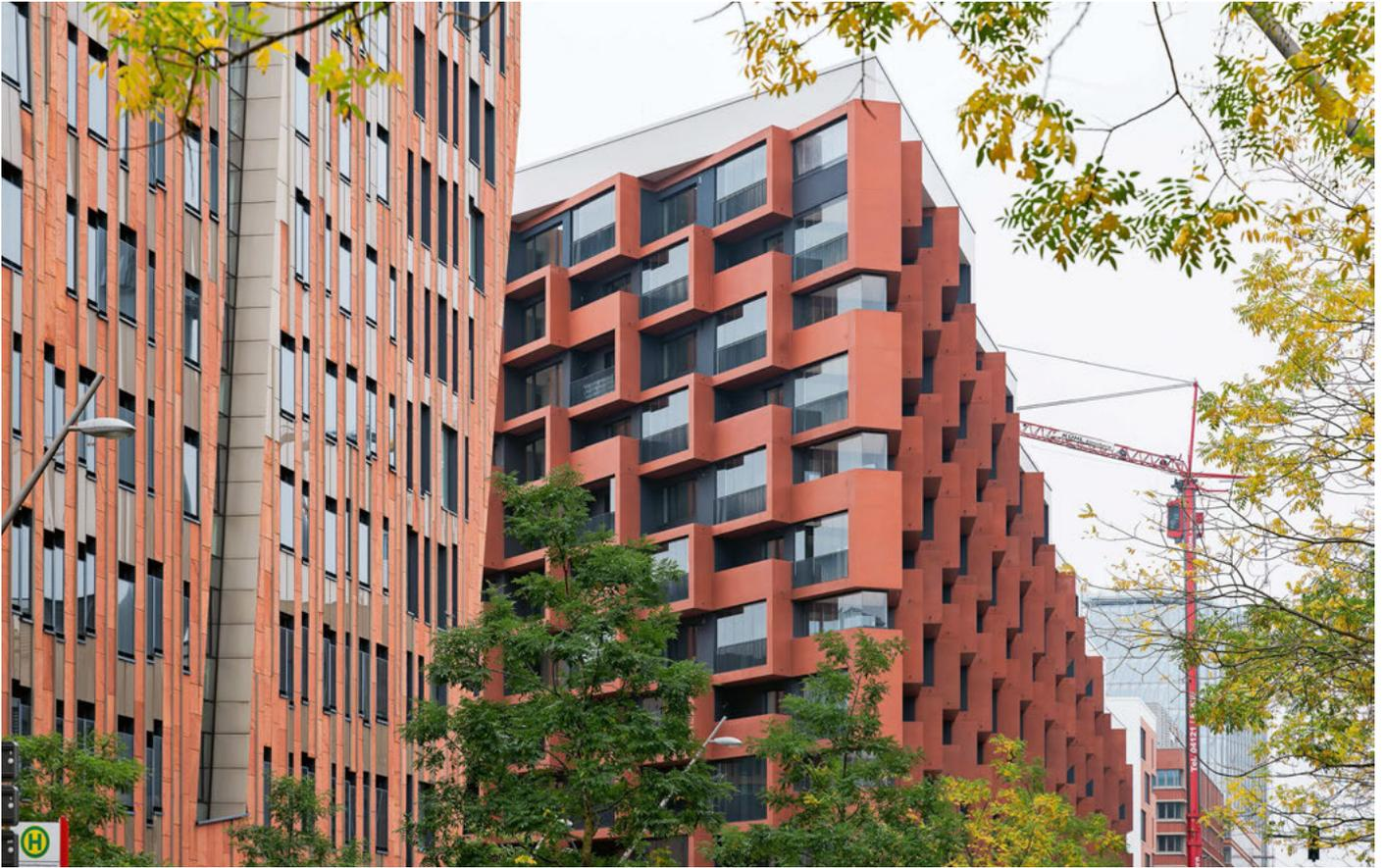
Das bis zu elf Geschosse hohe Gebäude stuft sich nach Süden mit grossen Dachterrassen ab. Die Balkone und Loggien aus durchgefärbtem Sichtbeton verleihen den Ansichten Tiefe und beleben die Fassade durch Licht- und Schattenspiele.
