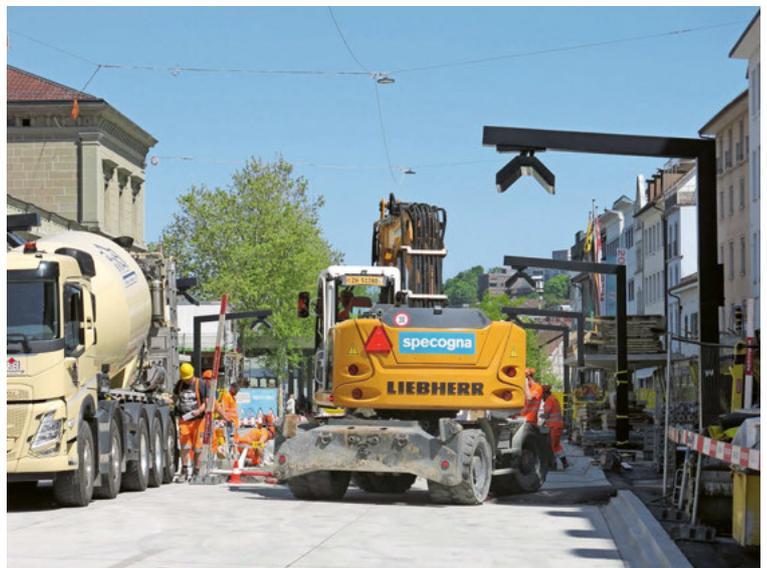
**Die Trottoirs werden auf sechs Meter verbreitert und neue Ladearme für die batterieelektrischen Busse installiert.**
