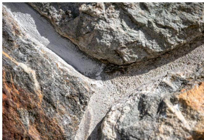
**Stützmauern an der Sustenpass-Strasse müssen aus denkmalpflegerischen Gründen von Hand instand gehalten werden. Die Fugen zwischen den Steinen müssen etwa einen Zentimeter tiefer liegen als üblich.**
